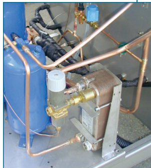
Platevarmeveksler for vannkjøling
